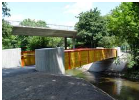
Bild 3: Seitenansicht mit Widerlager
