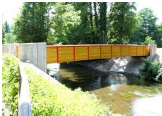
Bild 1: Ansicht von Norden
