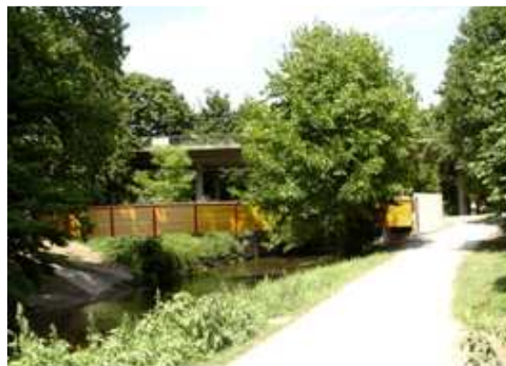
Bild 2: Ansicht von Süden
