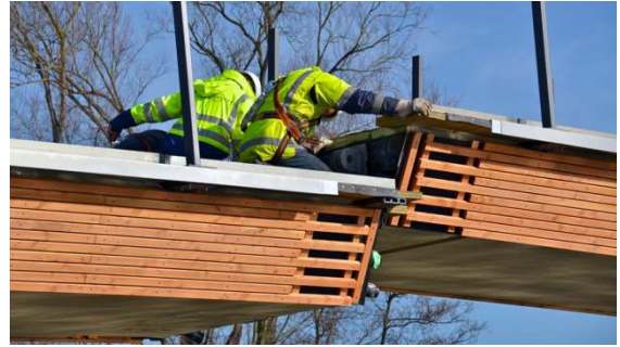
Bild 4: Einheben der blockverleimten BSH-Elemente.
