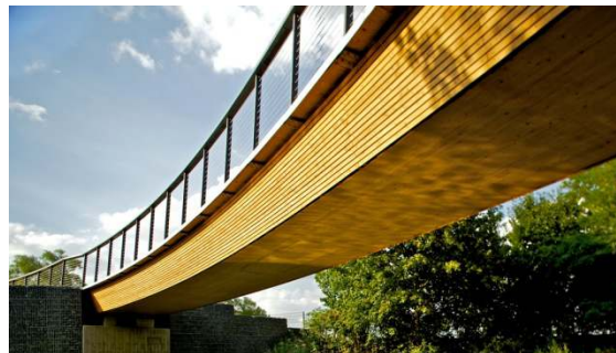
Bild 2: Geschwungener Brückenteil über den Mühlgraben.
