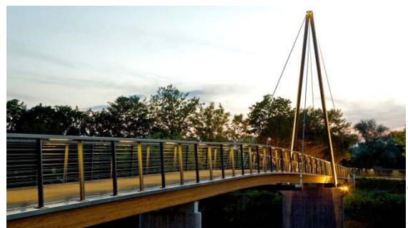
Bild 5: Beleuchteter Pylon in der Dämmerung.
