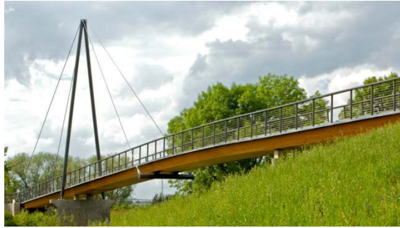
Bild 3: Ansicht des Hauptbrückenteils über die Lahn.
