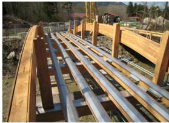
Bild 4: Während der Montage
