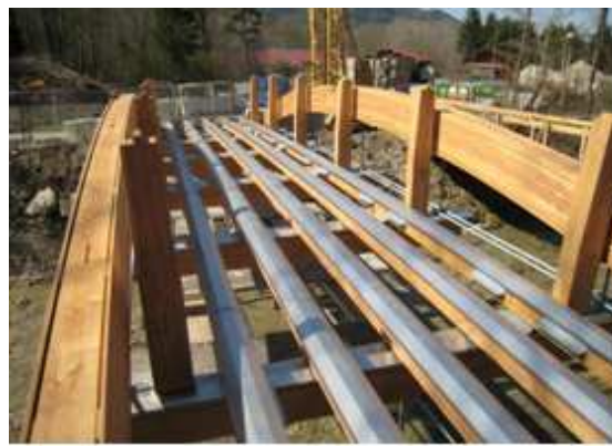
Bild 4: Während der Montage
