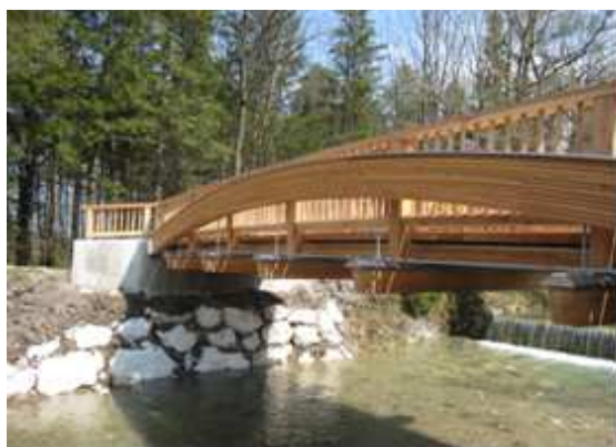
Bild 3: Ansicht von Norden
