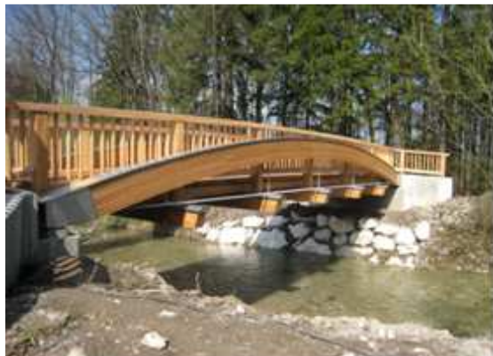
Bild 1: Ansicht von Süden
