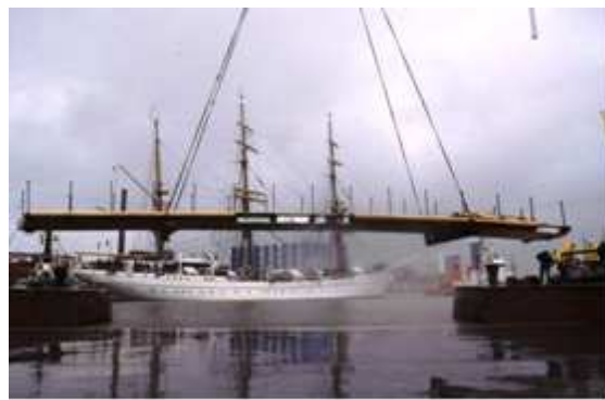
Bild 4: Ansicht von Westen während der Montage
