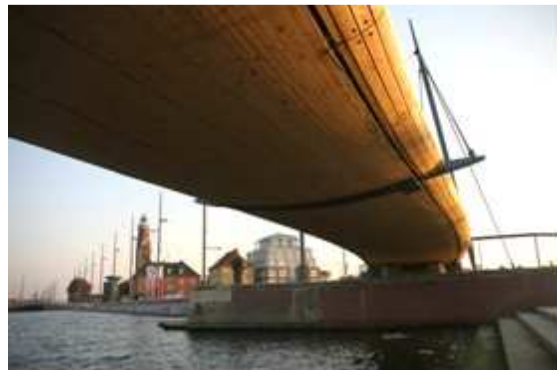
Bild 2: Ansicht von vorne
