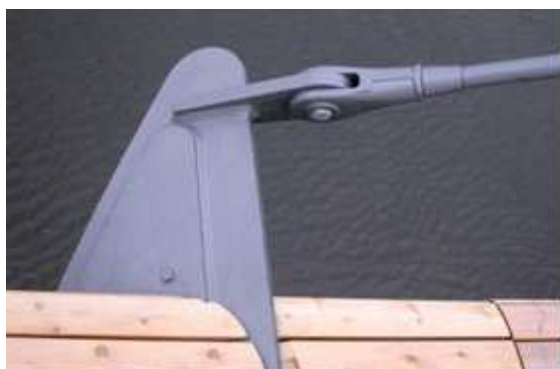
Bild 3: Ansicht von oben: Querträger der schrägen Brückenauftragung
