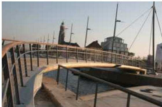
Bild 1: Ansicht von Westen
