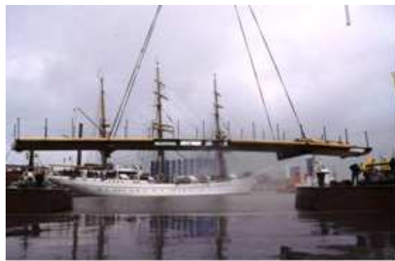
Bild 4: Ansicht von Westen während der Mon- tage
