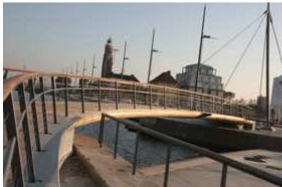
Bild 1: Ansicht von Westen
