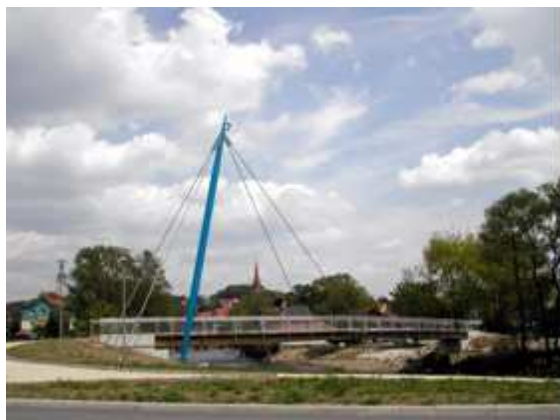
Bild 3: Ansicht von Süden
