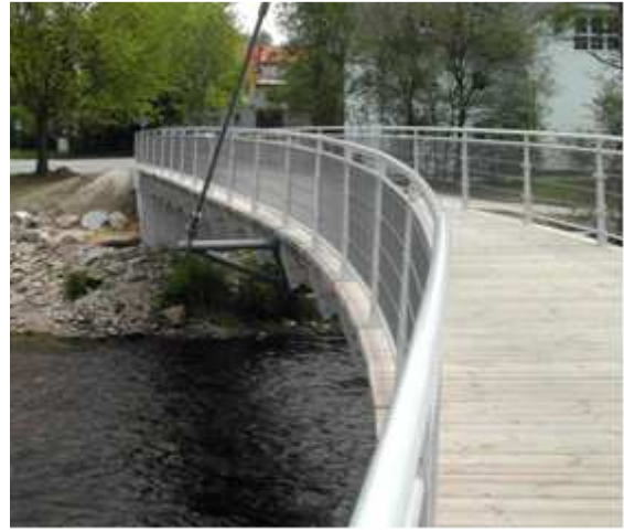
Bild 2: Ansicht von Westen aus das Stahlgeländer und Bohlenbelag aus Douglasie
