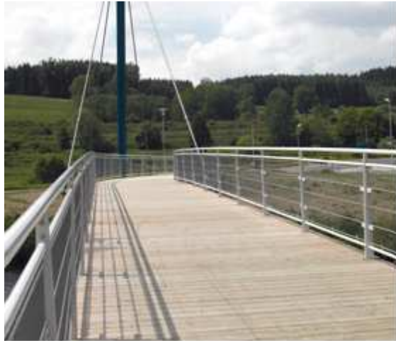
Bild 1: Ansicht von Osten auf die Pylonbrücke
