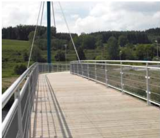
Bild 1: Ansicht von Osten auf die Pylonbrücke
