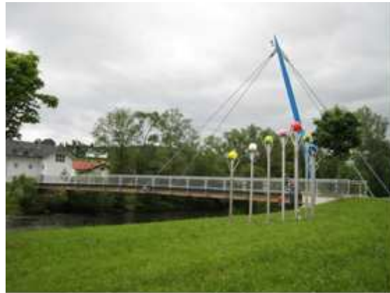
Bild 4: Ansicht von Norden
