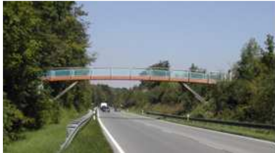
Bild 1: Ansicht von Süden
