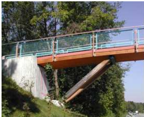
Bild 3: Ansicht Widerlager West
