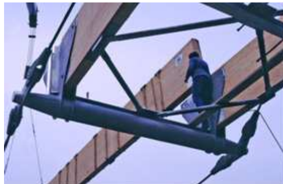
Bild 2: Montage des Obergurtes, Bauteil vom Mittelteil
