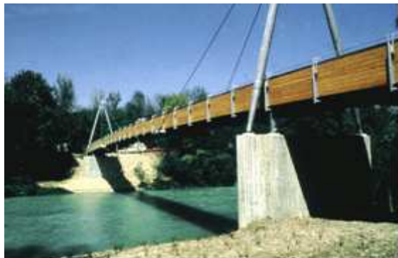
Bild 1: Ansicht von Süd-Ost
