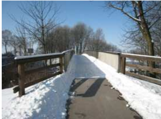
Bild 1: Ansicht von Westen
