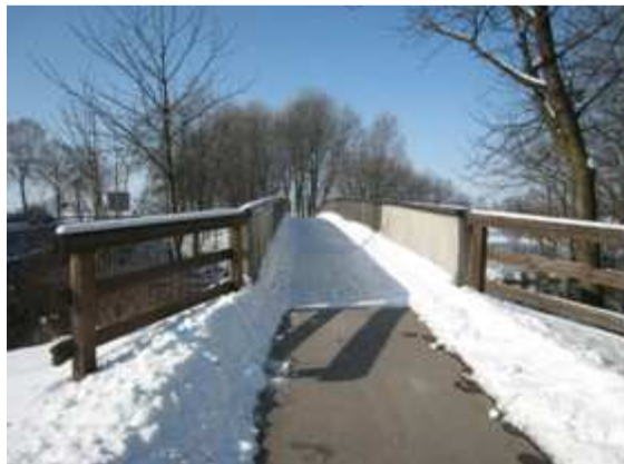
Bild 1: Ansicht von Westen
