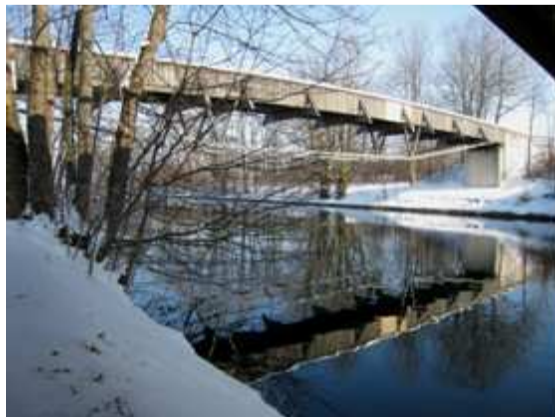
Bild 2: Ansicht von Süden
