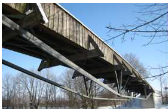
Bild 3: Ansicht von Unten
