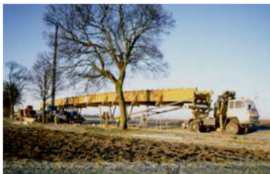
Bild 4: Ansicht von Westen
