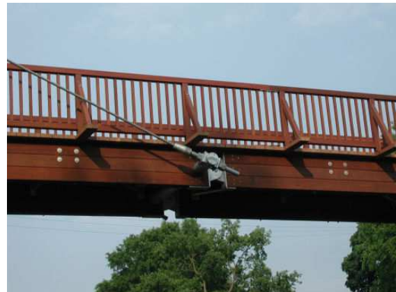
Bild 2: Detail Trägerstoß / Abspannung
