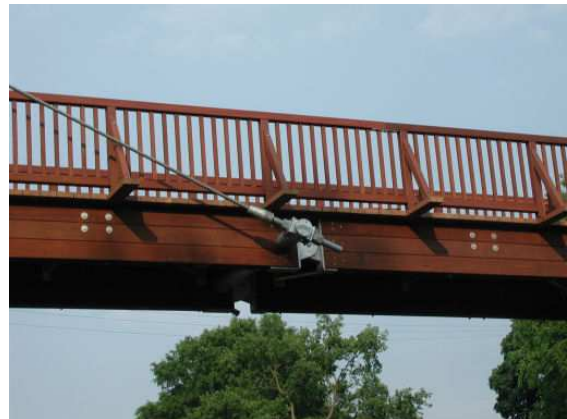
Bild 2: Detail Trägerstoß / Abspannung
