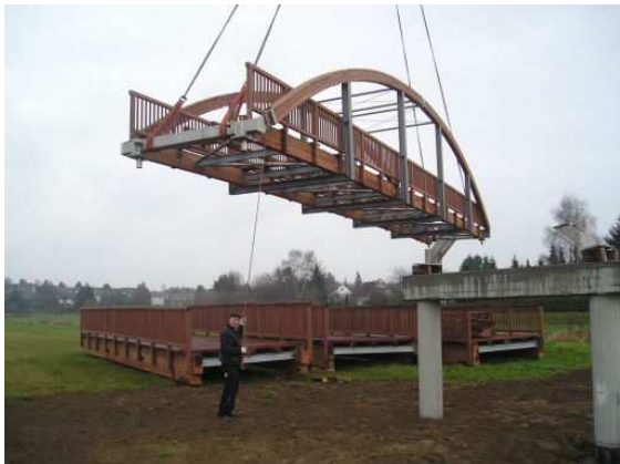
Bild 1: Montage des Bogenteils
