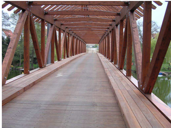
Bild 2: Das Haupttragwerk des Fachwerkträgers ist sauber und nicht beschädigt.
