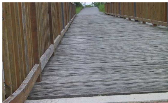
Bild 3: Bohlenbelag in einem sehr gepflegten Zustand. Weder starke Verschmutzungen, noch Vermoosung/Veralgung zu erkennen.
