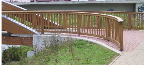
Bild 4: Geländer weist keine mutwillige Beschädigungen auf
