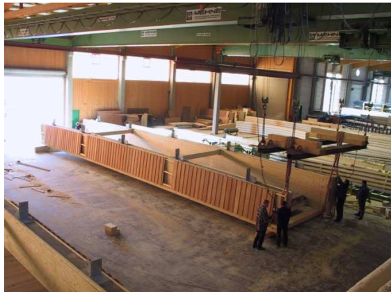
Bild 1: Vorfertigung einer Holzbrücke im Werk
