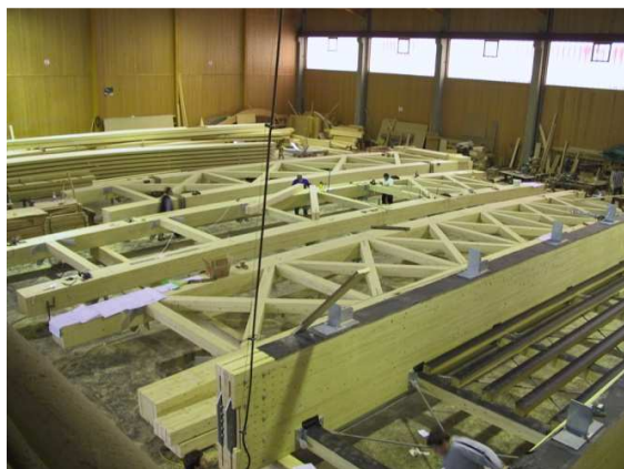
Bild 2: Fertigung der einzelnen Bauteile einer Holzbrücke im Werk
