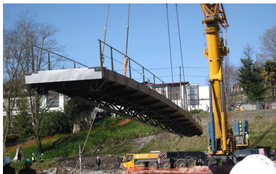
Bild 3: Montage einer Holzbrücke
