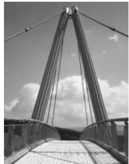
Bild 14.5 bewitterte Verschleißteile, wie Schrammbord und Geländerholm aus Eiche; Pflasterbelag wiederverwendbar
