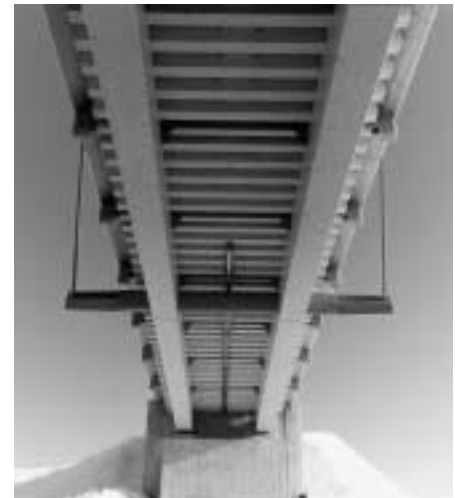
Bild 14.4 wasserdichte Fahrbahnplatte mit Überstand
