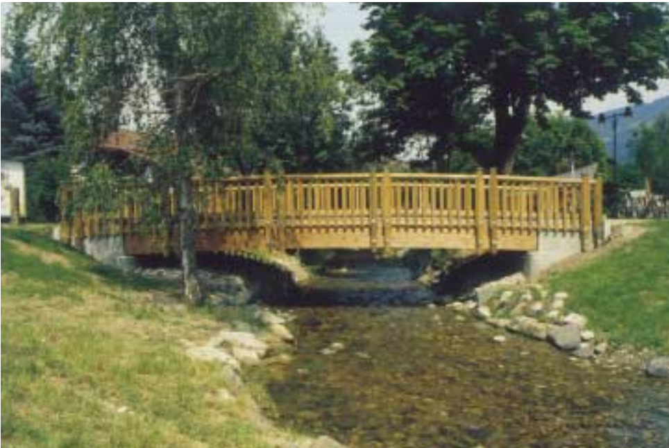
Kleiner Holzsteg, Geländer mit vertikalen Leisten, vgl. Bild 12.1
