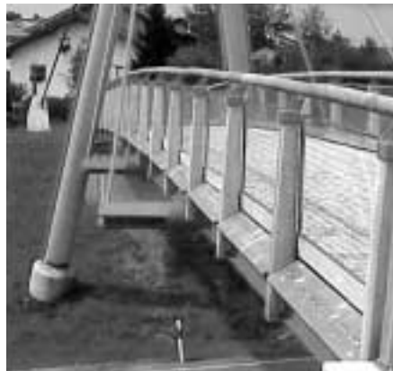
Bild 14.1 Abschirmung der Bauteile mit Wetterschutz und Schrammbord
