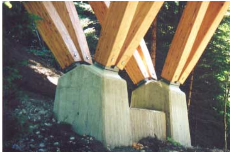
aufgelöste Strebenpaare auf einem Betonsockel, nur gelegentlich bewittert
