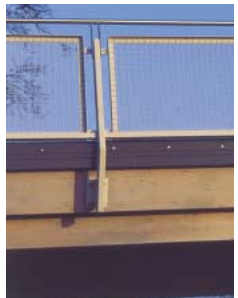
seitlicher Geländeranschluss bei einer blockverleimten Brú
