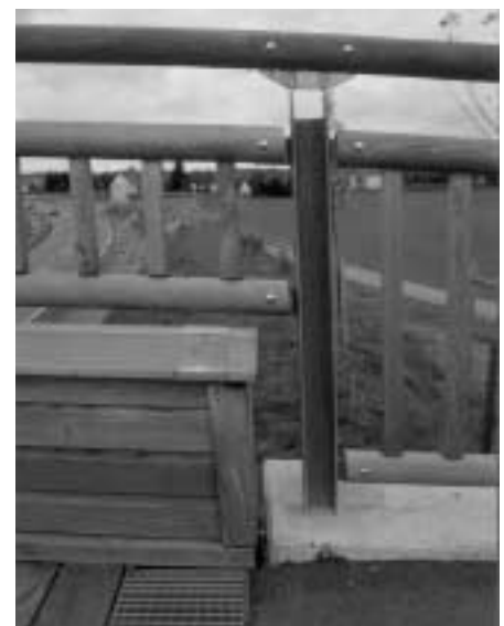
Bild 6.4 Obere Abdeckung eines Hauptträgers
