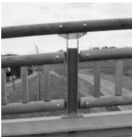
Bild 12.12 Aufgesetztes Geländer einer Trogbrücke
