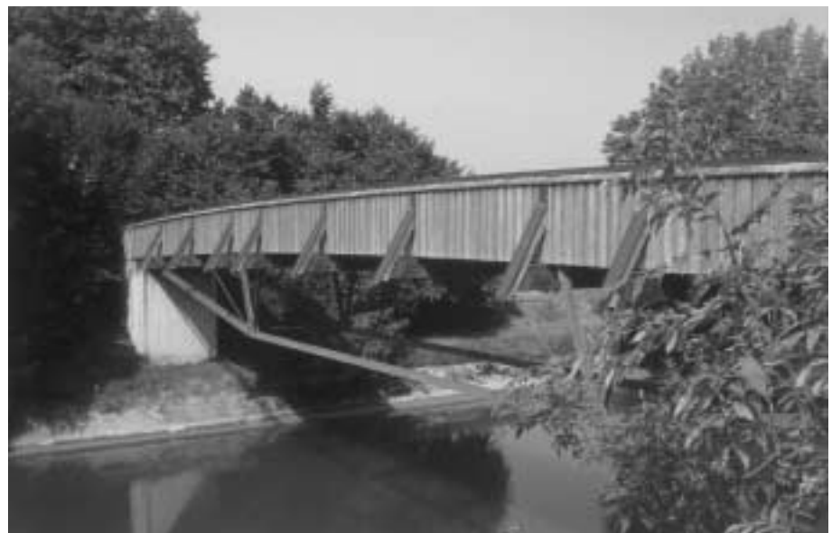
Bild 13.2 Verwendung von resistenten Holzarten als Witterungsschutz
