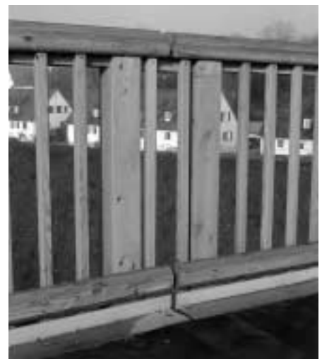
Bild 12.22b Handlauf profiliert, beim Stoß mit Abstand ausgebildet
