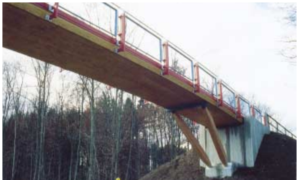
seitlicher Geländeranschluss bei einer abgestrebt blockverleimten Brücke
