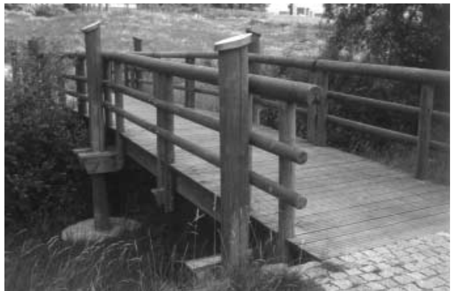
Bild 13.1 Baulicher (z.B. Abdeckungen) und chemischer Holzschutz (z.B. Geländer, Stützen, Längsträger) bei einer Brücke aus Rundhölzern
