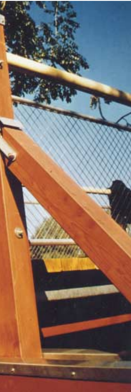
er; Pfosten und Strebe auswechselbar
