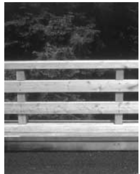
Bild 12.9 Holmgeländer bei einer abgelegenen Straße; mit der Bauaufsichtsbehörde abgestimmt
