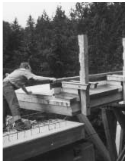
Bild 6.3 Deutlich sichtbar sind hier die Abdeckungen der Träger und die Flächenabdichtung
