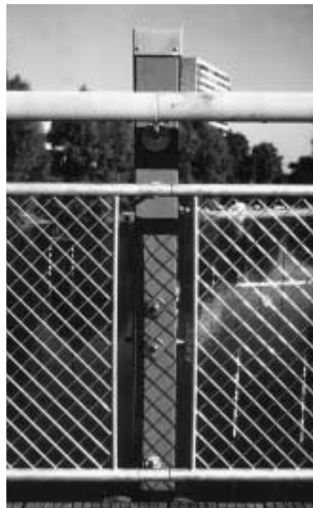
Bild 12.8 Geländerfüllung mit Stahlgitter
