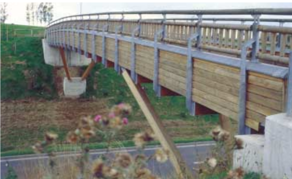
Trogbücke mit aufgestztem Geländer, seitlich bekleidete und oben abgedeckte Hauptträger
