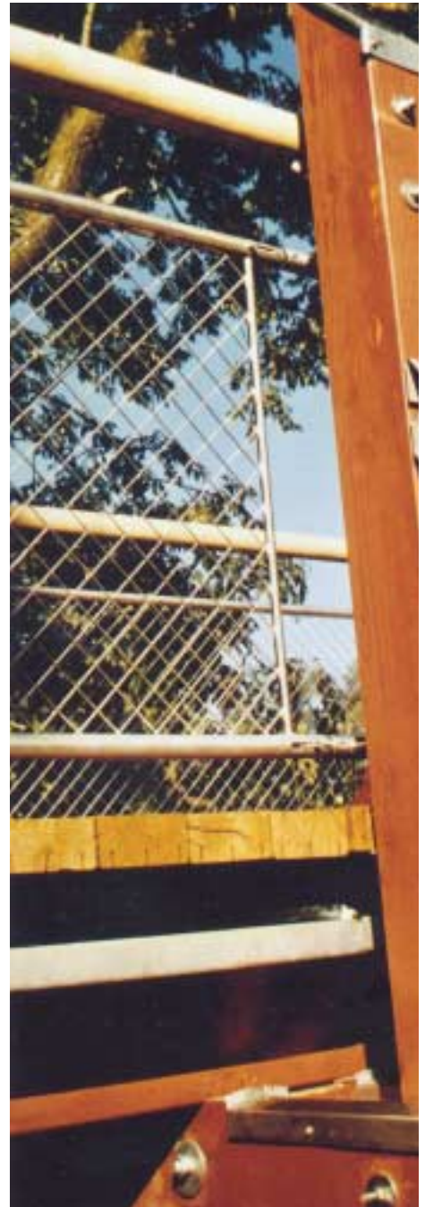
abgestrebter Geländerpfosten und abgedeckte Querträge
