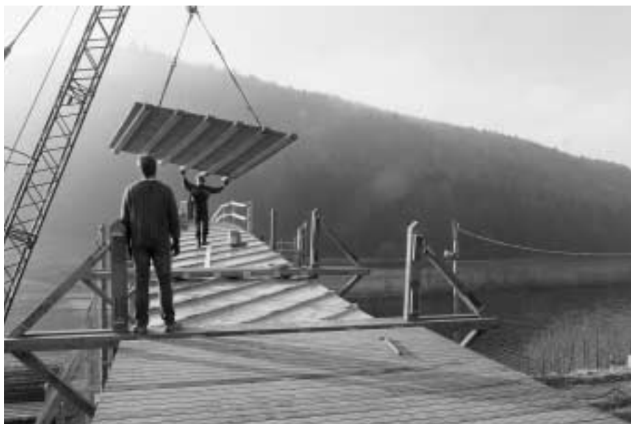
Bild 2.10 Bohlenrost auf Blechabdeckung
